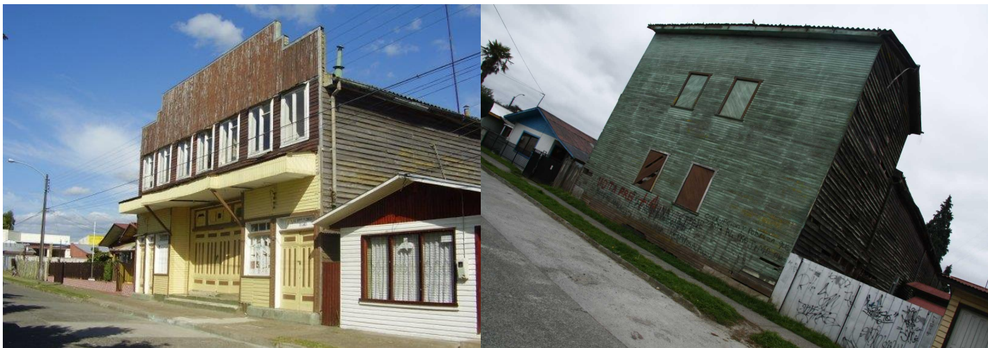
Fotos de vistas de las fachadas exteriores hacia la Plaza de Armas y hacia la calle posterior
