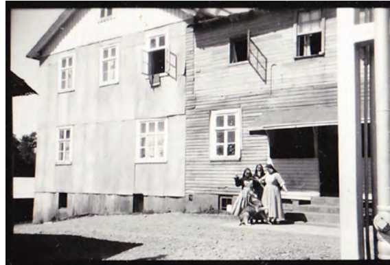
Fotografía casa parroquial, y parte de pabellón agregado (orfeón) donde funcionó también la escuela y el internado misional. En Villanueva, M. (2014). Misión de Pelchuquín: 1950-1980.
