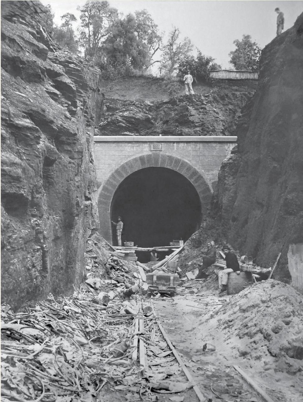
Túnel Los Venados situado a la salida sur de la estación de Los Lagos. Su construcción fue el mayor desafío que se enfrentó en el despliegue de este ferrocarril. Esta es la boca norte en 1887.
