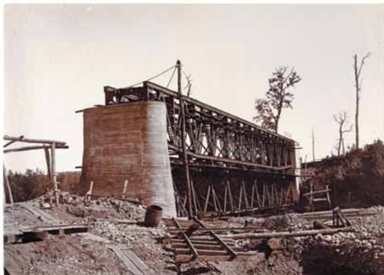
Fig. 127. Construcción del ferrocarril en Antilhue ca. 1902. "Archivo fotográfico Ellynor Fehrenberg" del Centro Cultural el Austral de Valdivia.
