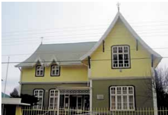
Fig. 47. Patrimonio arquitectónico en buen estado de conservación. Biblioteca Municipal. Comuna Río Bueno.
