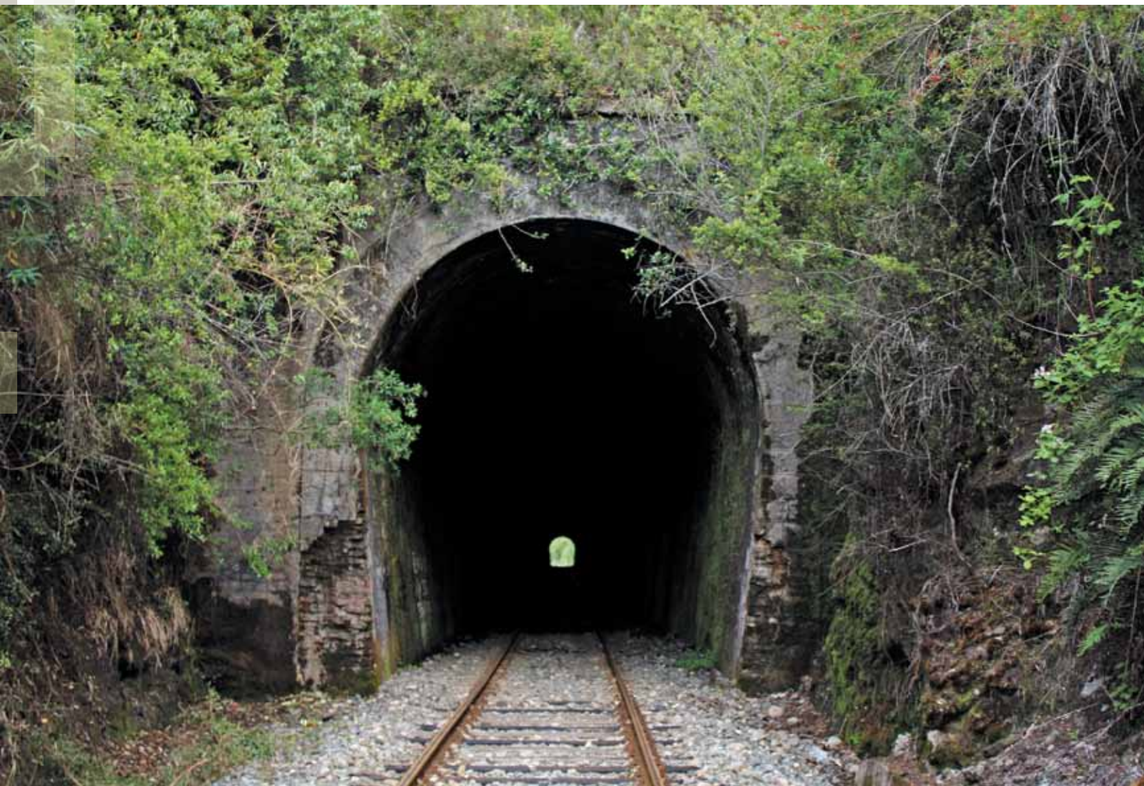
Fig. 6. Túnel ferroviario. Comuna Los Lagos.
