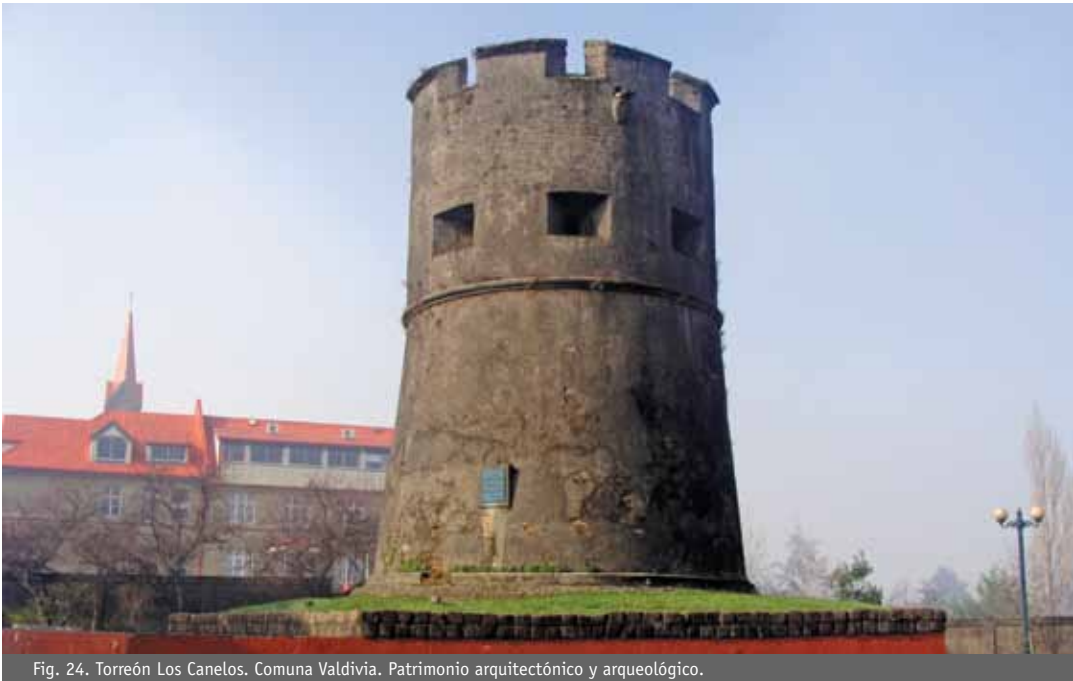
Fig. 24. Torreón Los Canelos. Comuna Valdivia. Patrimonio arquitectónico y arqueológico.
