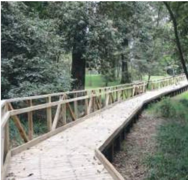
Pasarela Parque Urbano El Bosque, Valdivia
