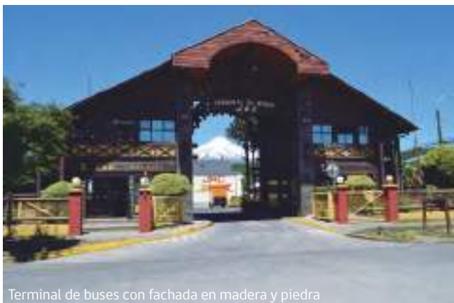
Terminal de buses con fachada en madera y piedra
