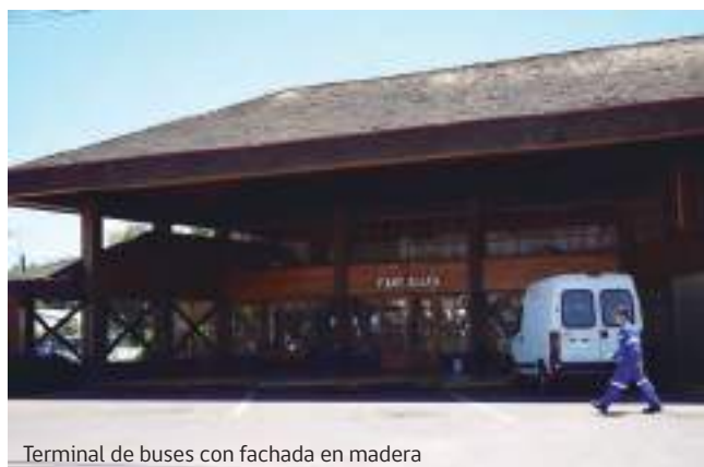
Terminal de buses con fachada en madera
